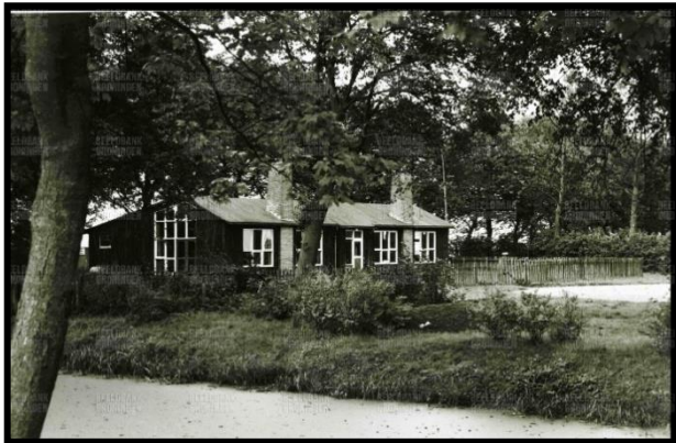
Padvindersgebouw aan de Boerhaavestraat in Stadskanaal Noord (1968).
